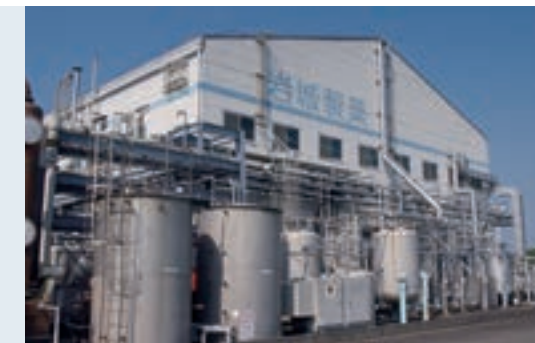
静岡工場（外観）
