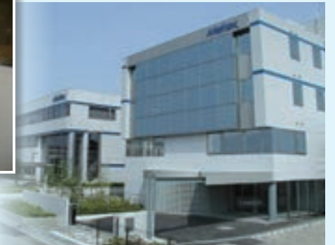
技術研究所とCSセンター外観
